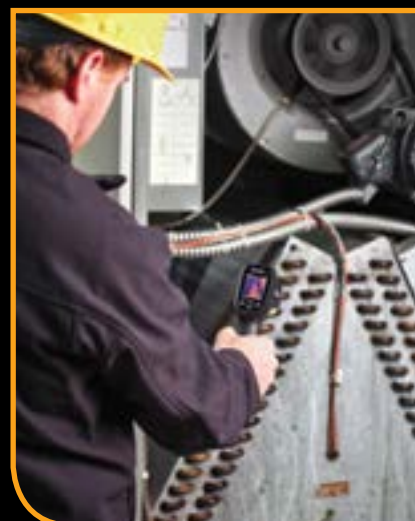
Inspecões de Ar Condicionado
